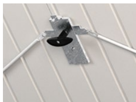
Lås med en låscylinder som spärrar porten på båda sidor
