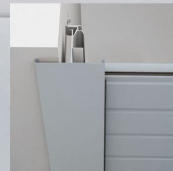
Installation i öppningen – kontrollpanelen framför öppningen
